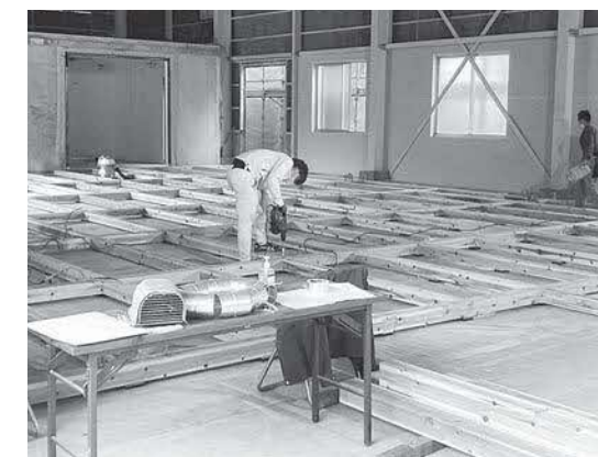
福原集荷所 改築初期工事の様子 改築費 9,050万円
