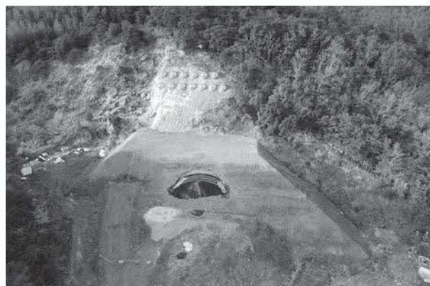
四国横断道路 羽ノ浦トンネル 南坑口現況 (2022年12月26日撮影)
