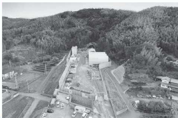
四国横断道路 羽ノ浦トンネル 北坑口現況 (2022年12月26日撮影)
