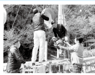
3月4日に行ったカーブミラー 交換の様子
