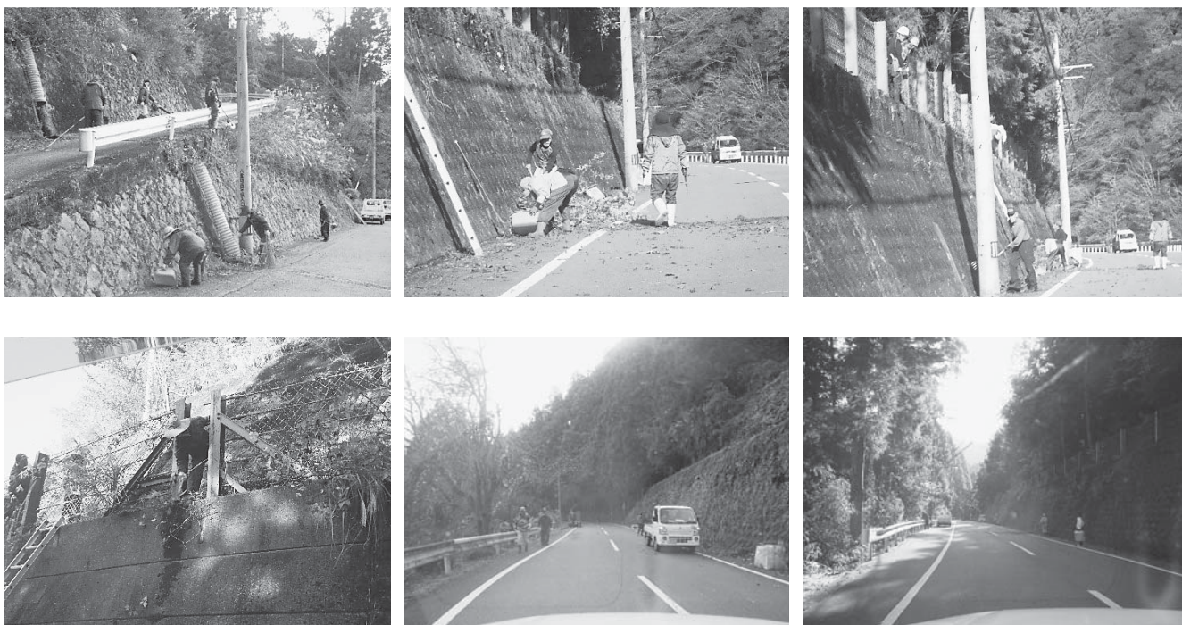
作業中の様子(抜粋)
