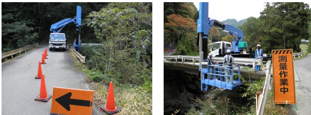
写真2 H23年度橋梁点検状況（橋梁点検車使用）
